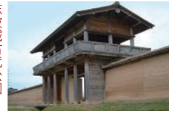
志波城古代公園 外郭南門
